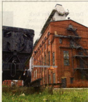
4 Energiegeschichte mit Kohle
